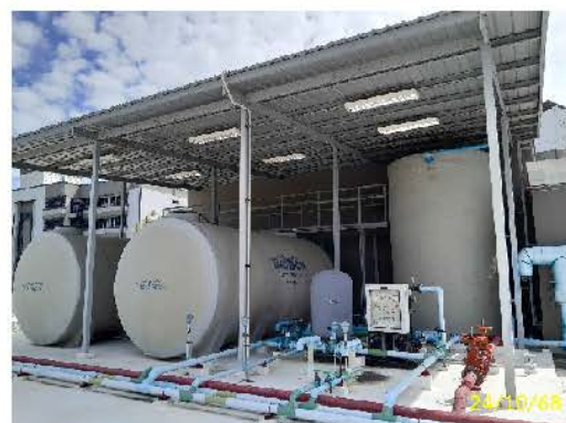
ปั๊ม และถังสำรองเพื่อการอุปโภค-บริโภค ชั้นตาดฟ้า
