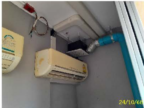
เครื่องปรับอากาศ และระบบระบายอากาศห้องพักขยะรวมเปียก
