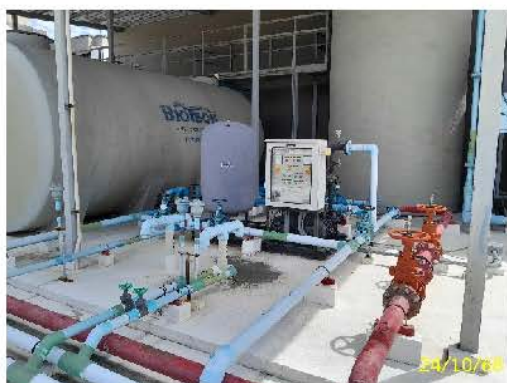
ปั๊ม และถังสำรองเพื่อการอุปโภค-บริโภค ชั้นตาดฟ้า
